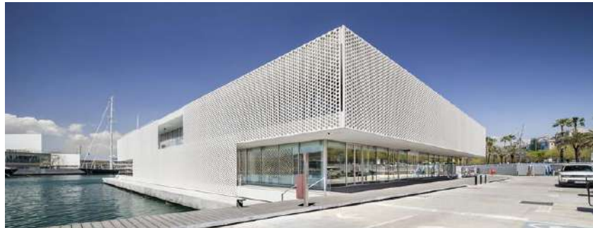
Imagen 3. Vista lateral del edificio de servicio de la marina.
