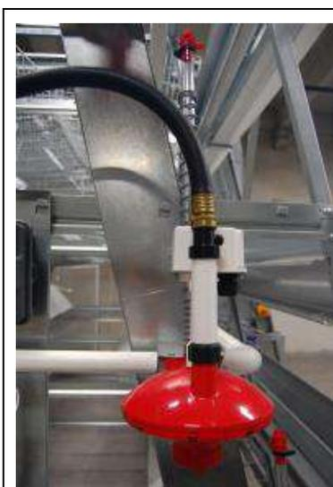
Reguladores de presión, con electroválvula (opcional) que permite programar el flushing del sistema en forma automática para controlar la temperatura y la calidad del agua en la tubería
