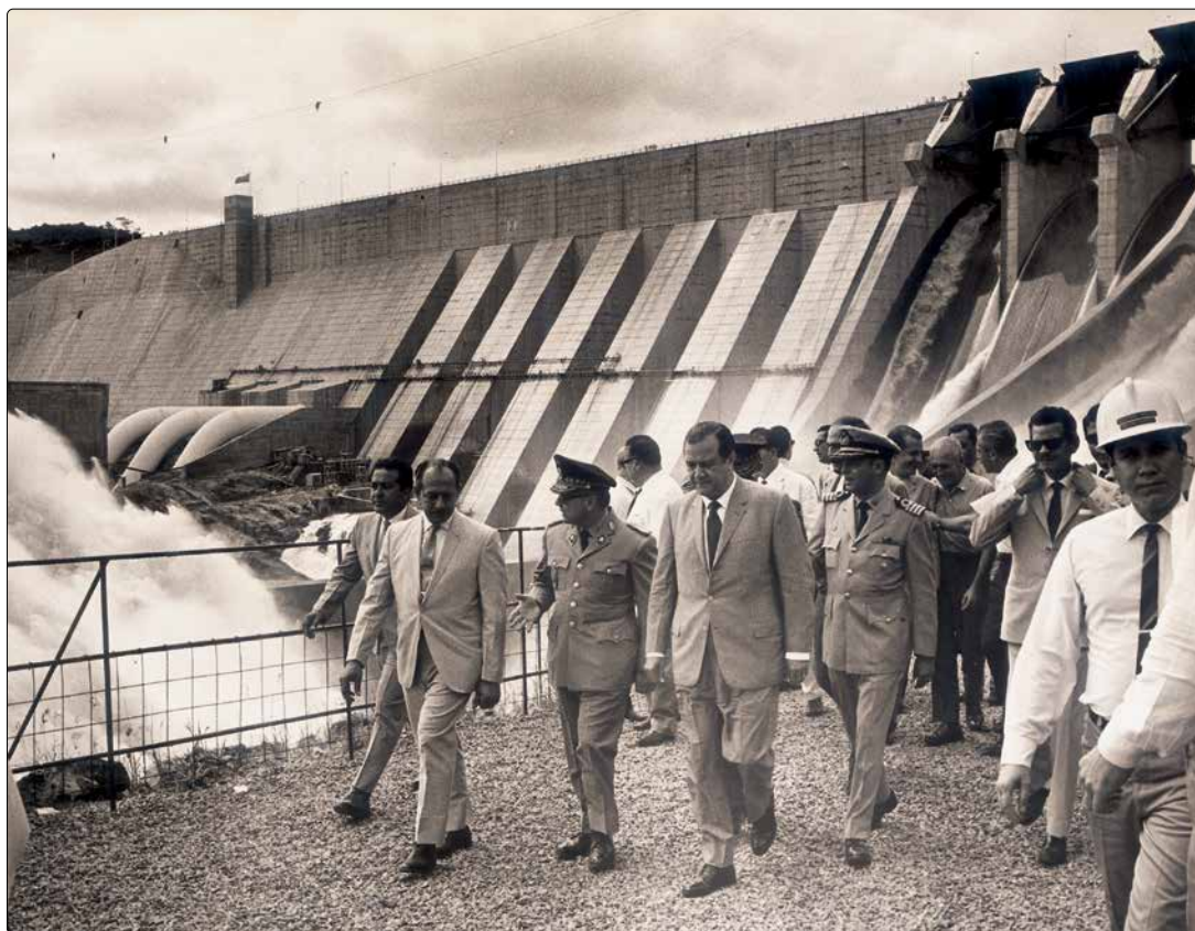
Inspeccionando los aliviaderos de Guri junto al presidente Rafael Caldera.
