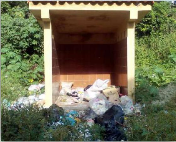
Los botes son estructuras de bloque y cemento, diseñadas para el depósito de residuos, construidas y ubicadas en diferentes sectores del municipio Trujillo, para que en las zonas que no pueda llegar el transporte de aseo, depositen allí los residuos que se generan.
