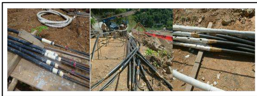
Figura 9. Confección guayas de anclaje. Fuente: Información tomada de los documentos y expedientes con autorización de FF.
