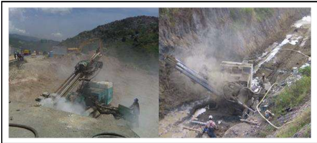
Figura 7. Perforación de anclajes. Fuente: Información tomada de los documentos y expedientes con autorización de FF, 2012.
