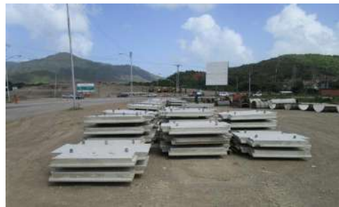
Figura 31: Patio de acopio Fuente: Archivos Tierra Armada
