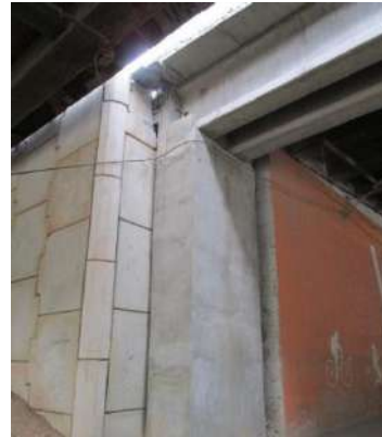
Figura 38: Muros Rampa Oeste Fuente: Archivos Tierra Armada
