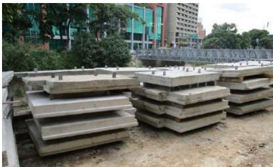
Figura 39: Muros Rampa Este Fuente: Archivos Tierra Armada
