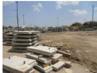
Figura 43: Acopio de escamas Fuente: Archivos Tierra Armada
