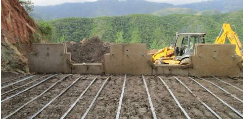
Figura 22: Colocación de pletinas Fuente: Archivos de Tierra Armada (2018)
