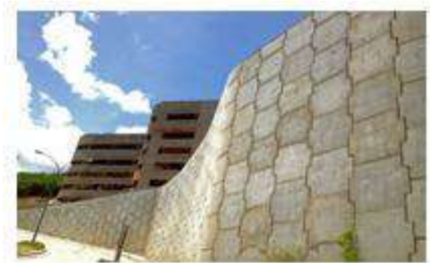
Figura 18: Acabado de escama obra limpia Fuente: Archivos Tierra Armada Venezuela (2018)
