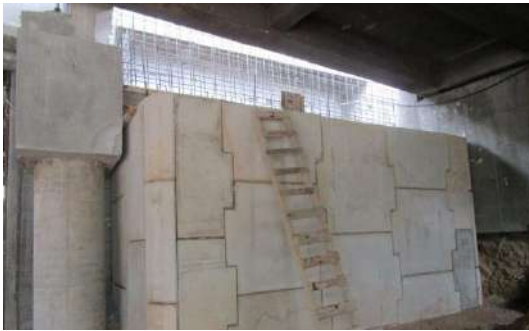
Figura 37: Muros Rampa Este Fuente: Archivos Tierra Armada
