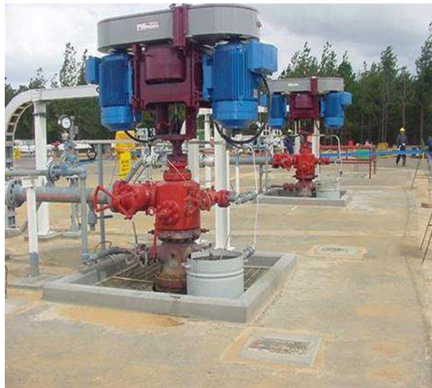
Figura 6.3. Cabezal de Producción con Bomba de Cavidad Progressiva Fuente: GPM Instrumentación y Control, C.A. (2017)
