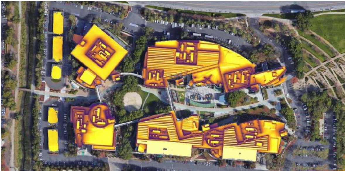
Figura 3.4 Techos de edificaciones en Houston con condiciones para generación distribuida Solar
