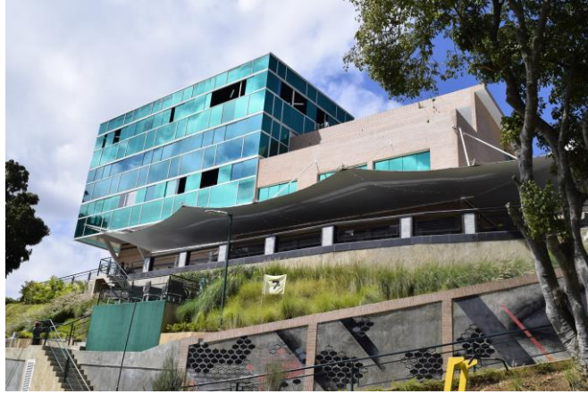
Club Padel- Exterior
