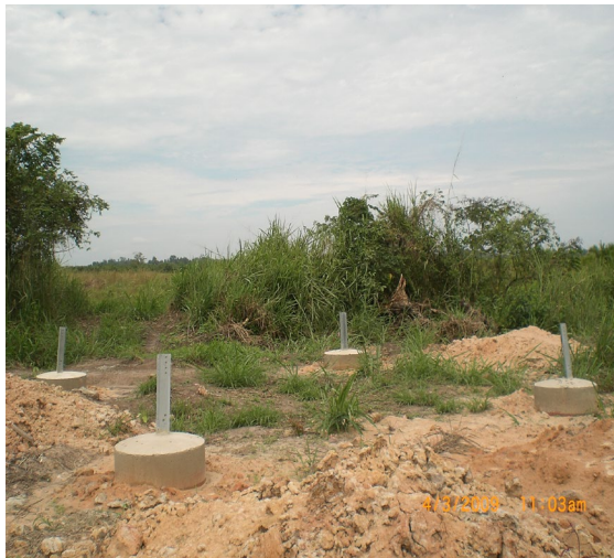
Figura 2-15 Fundaciones tipo pilotes. Colorado, D.
